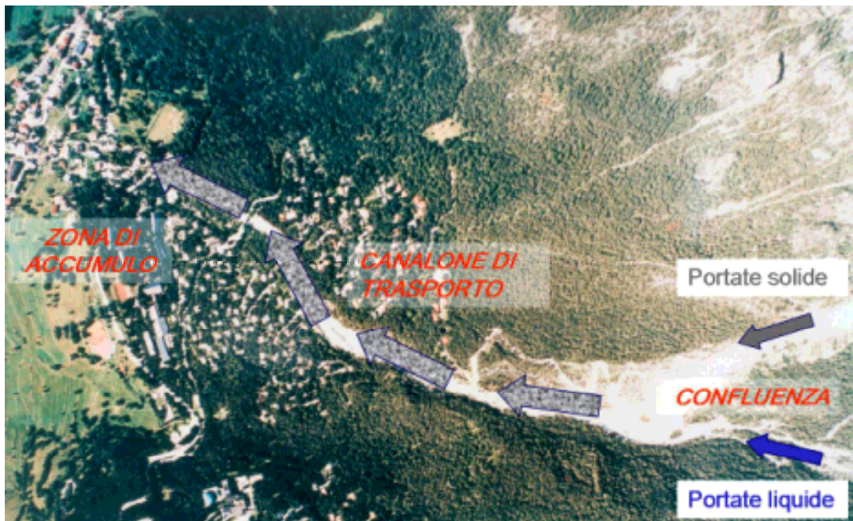
Figura 1. Vista aerea dell'area interessata dalla colata. E' stata evidenziata l'area di confluenza delle portate prevalentemente solide e prevalentemente liquide (area di formazione della colata), il canale di trasporto e la zona di accumulo.
