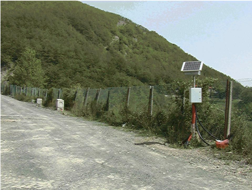
*Centralina completata con l'installazione del pannello solare di alimentazione*
