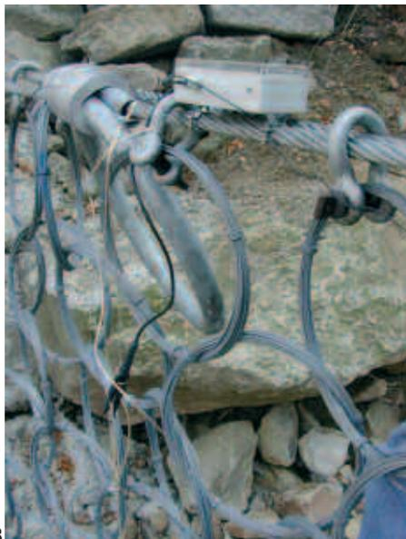
sia dal punto di vista elettrico, in quanto risulta nettamente ridotto il rischio che la caduta di fulmini nei dintorni dell'impianto possa imprimere, per effetto antenna, elevate correnti parassite in grado di compromettere la funzionalità dell'elettronica di controllo.
