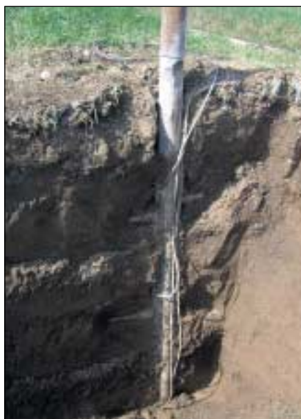
Sezione successiva all'installazione di micropalo con sistema TFEG
