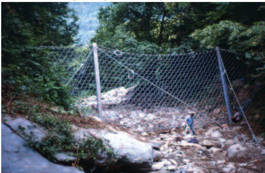
duato, pioniere in Italia, l'applicazione di una barriera flessibile contro i Debris Flow per proteggere l'abitato di Garnier, attraversato dal Torrente Sautoreglia, dalle colate detritiche che si ripetevano lungo l'alveo con forti rischi di esondazione all'intersezione con la principale strada di accesso al paese.
