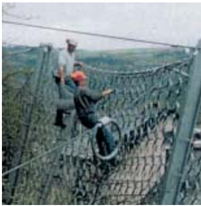
Installazione della rete ad anelli
